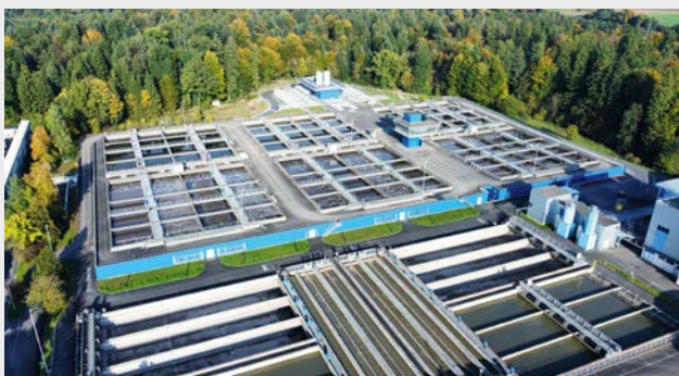
Die ARA Buholz in Emmen ist die grösste Abwasserreinigungsanlage der Zentralschweiz. (Bild REAL)
